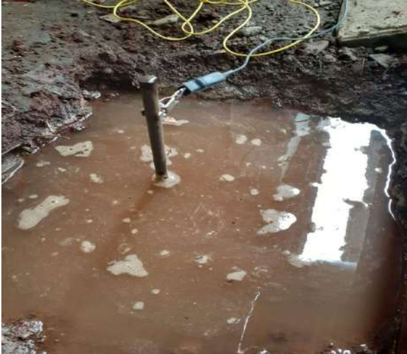
Gambar 3. Pemasangan Grounding dengan sumur resapan
