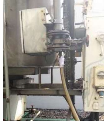
Gambar 3. Pembuangan minyak dari tangki minyak OLTC
