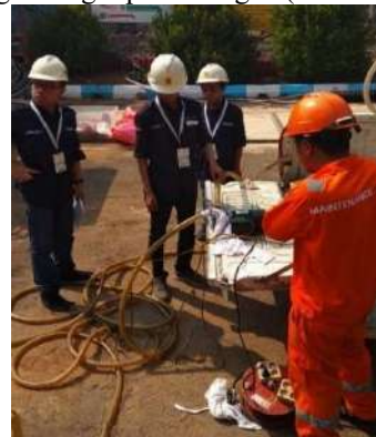
Gambar 4. Penyedotan minyak dari tangki minyak OLTC menggunakan pompa
