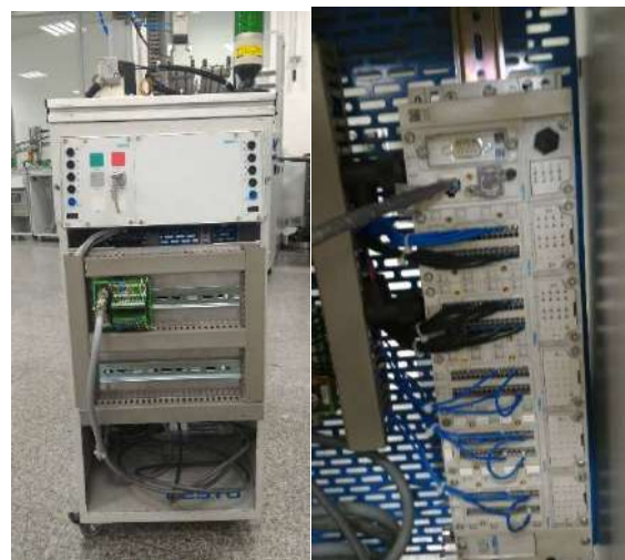
Gambar 5. Hasil instalasi komponen elektrik
